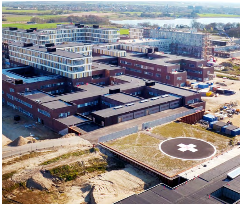
DNV-Gødstrup under opførelse. Foto: Hospitalsenheden Vest, Region Midtjylland
