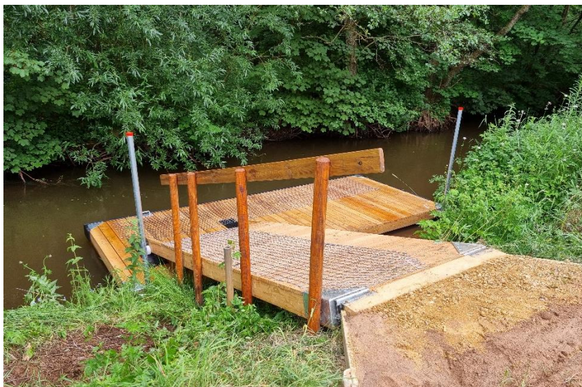
Ny kanoisætningsbro ved Arnborg. Foto: Peter Nedergaard Jensen
