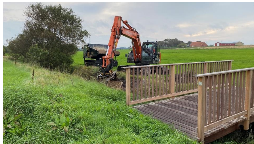
Entreprenørmaskine i gang med at lave en gydebanke i Bærkær Bæk ved Vind. Broen er en del af en ny trampesti fra Vind til Skjernvej. Foto Michael Gramkow
